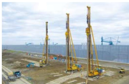
SIMAR工法による埋立て地盤改良工事(常陸那珂火力発電所)
