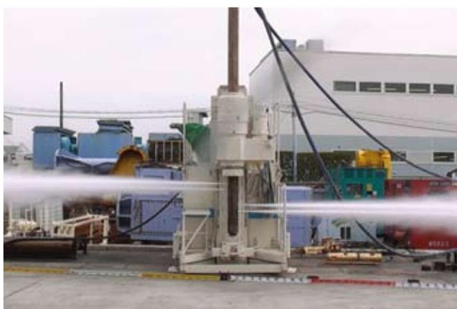
マルチジェット工法の施工マシンによる噴射状況
