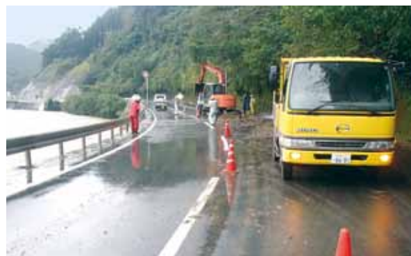
集中豪雨時の道路災害復旧作業の様子
