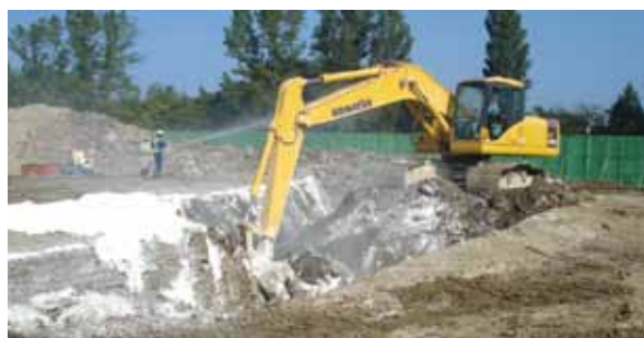
改質材の散布・混合による汚染土の改良状況
