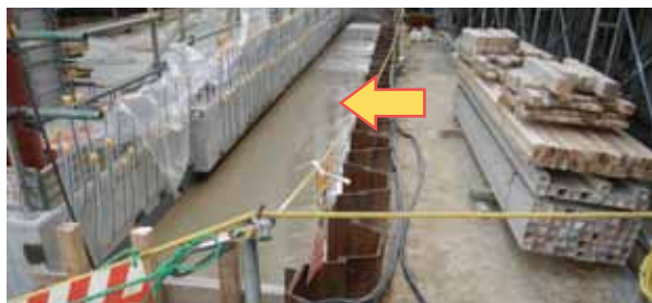
再資源化した流動化処理土の打設状況
