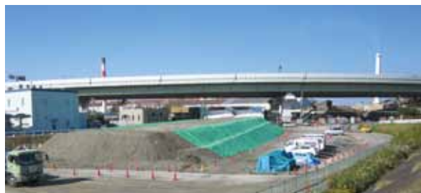
工区内発生土仮置き状況
