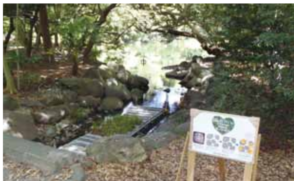
写真① 護国神社の神池の流入口に設置した礫間接触酸化槽
