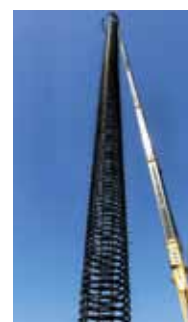
地中熱交換器設置状況
