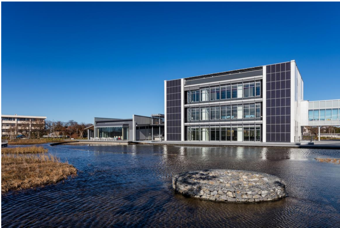
ICI Lab エクステンジ棟
