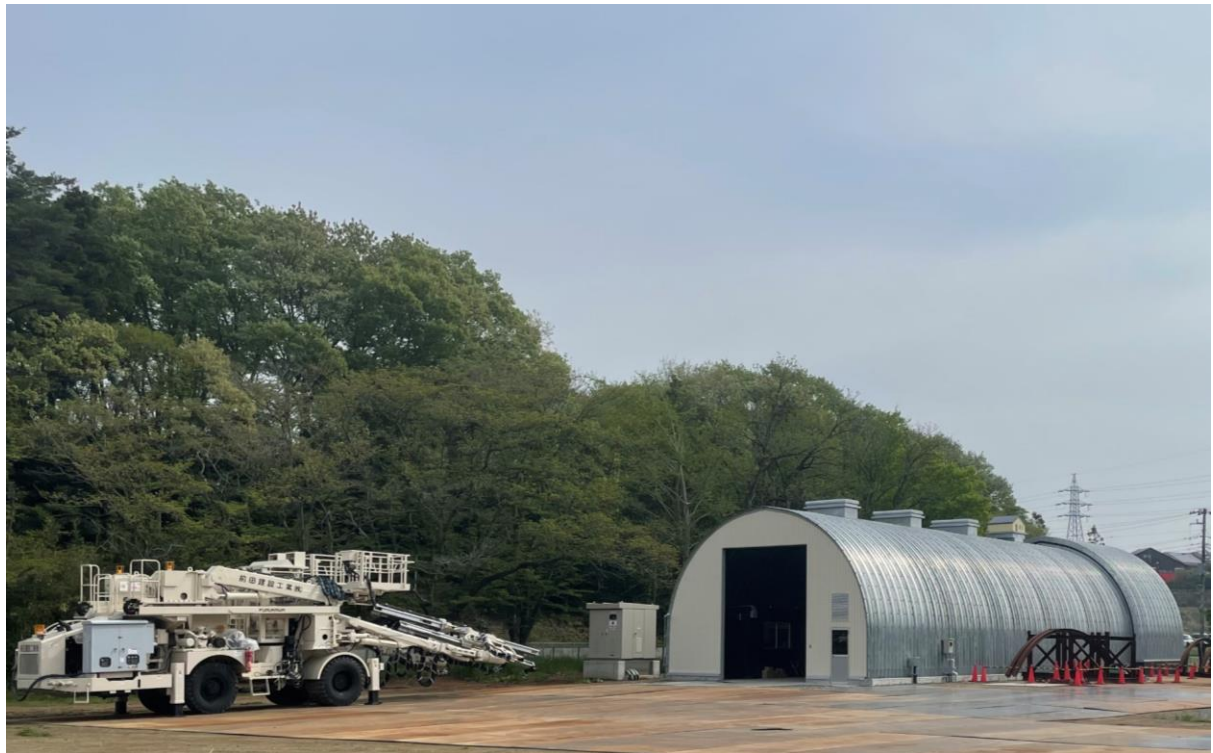
写真1 ICI総合センター模擬トンネル全景
