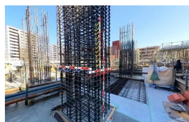
仮想スケールを配置した 目視検査(柱)
