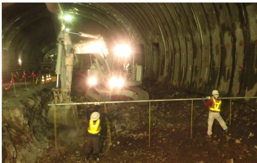
写真-2 従来の掘削高さ確認方法
