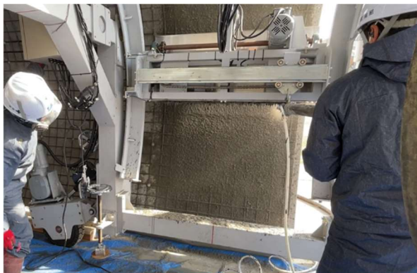
写真-7 吹付け試験状況
