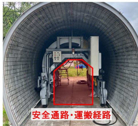
写真-6 ICI 模擬トンネル
