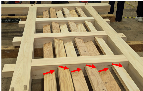
写真2: 「^ (キャレット)」状にジグザグに配置した縦材
