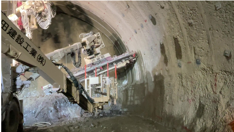
写真－2 施工状況
