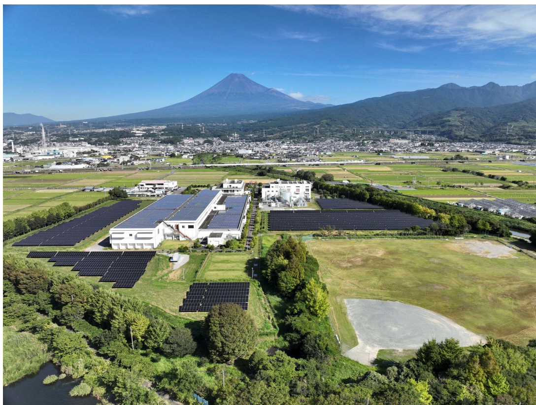
ふじサンエネルギー発電所 全景写真
