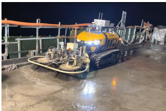
写真-2 グリーンカット施工状況
