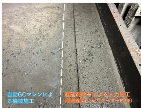
写真-3 打継面 (グリーンカット後)
