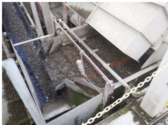
骨材洗浄状況
