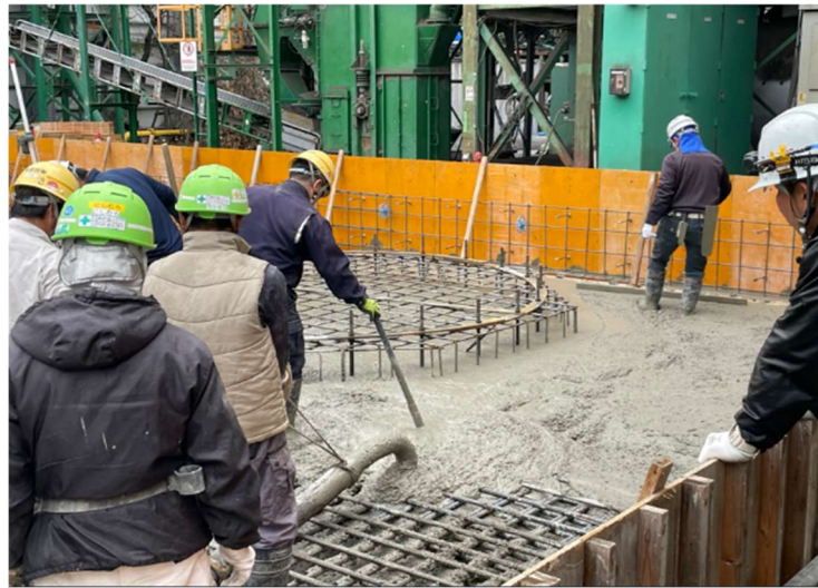
グリーン骨材を使用したコンクリート打設状況
