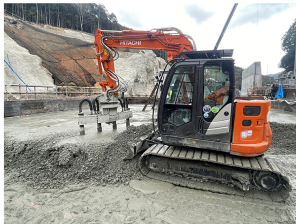
写真-2 バイバックによる施工状況
