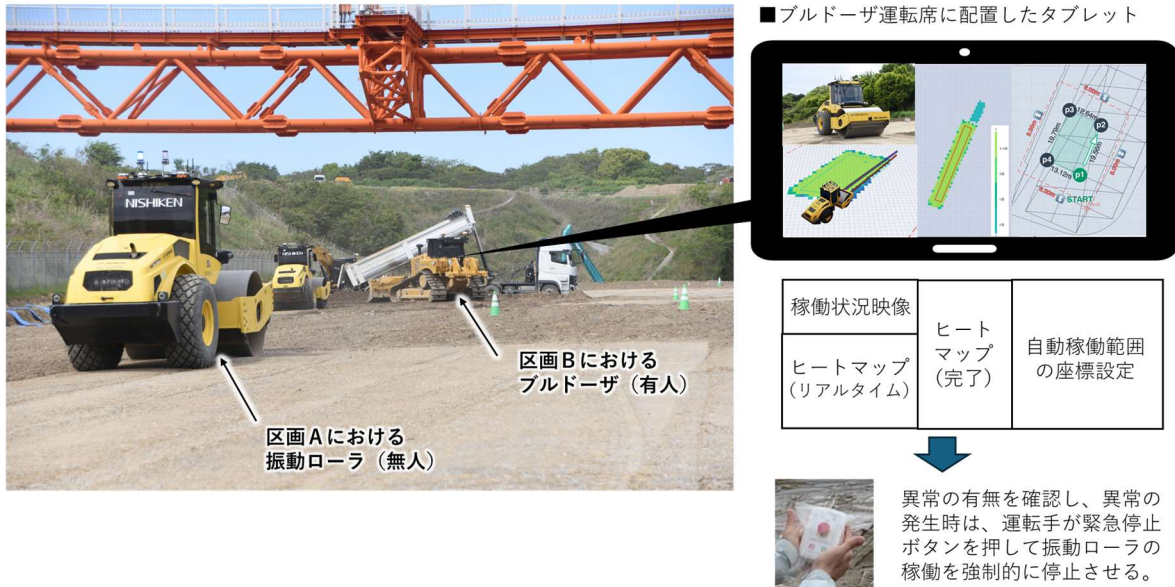
写真-1 自動運転する振動ローラの施工状況
