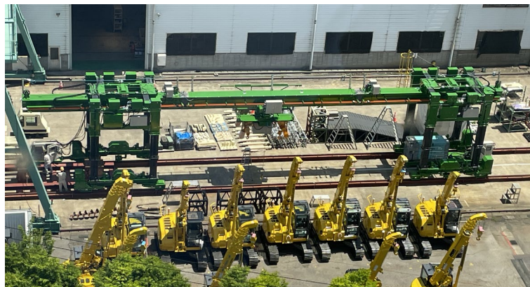
写真-2 連結式半断面床版架設機「どすこいガントリー」（上方より）
